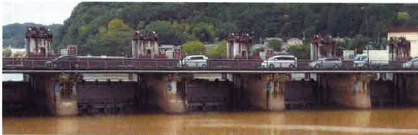
瀬田川洗堰全閉状況：下流右岸より撮影
