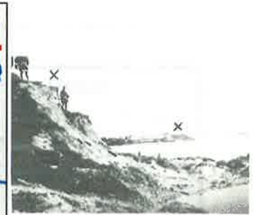
大正6年決壊箇所状況写真(淀川右岸大塚村大塚)
